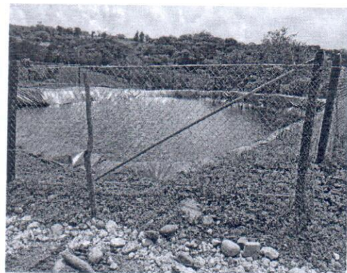
Reservorios de agua para Mitigación Cambio Climático.
